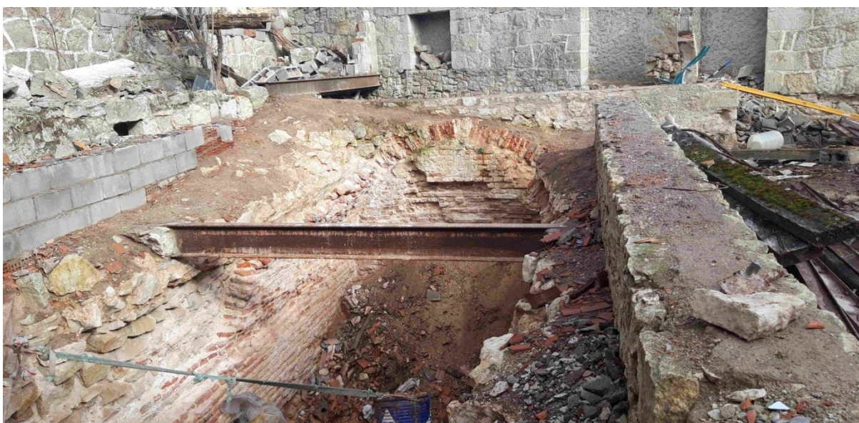
Aljibe descubierto – Retirada de escombros que se habían vertido en el interior
