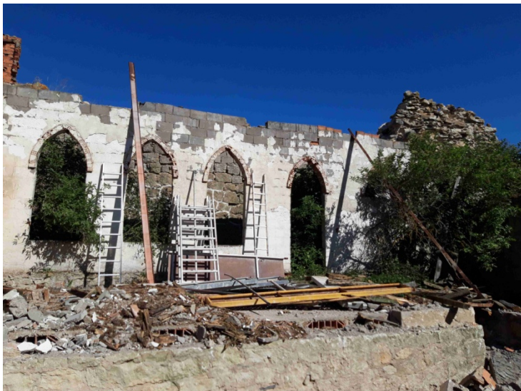
Paño fábrica de bloque
